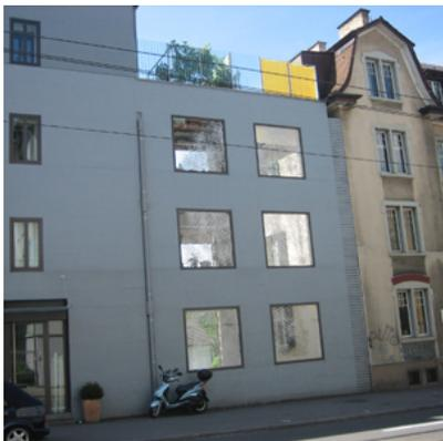
Lärmschutz durch Zwischenbauten (Loggien)
