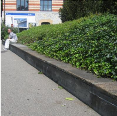
Betonmauer mit Abdeckung
